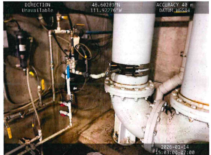
Effluent sampling point.
