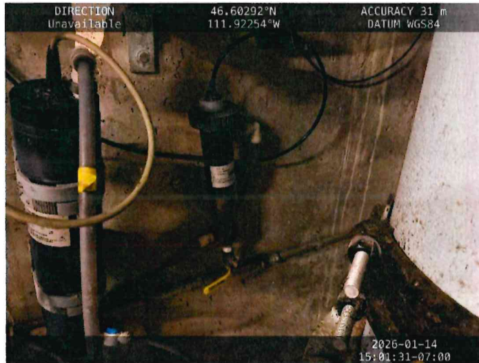
Effluent pH meter / probe.
